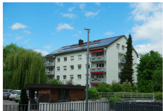
Alemannenweg 3 vor und nach der Fassadensanierung
