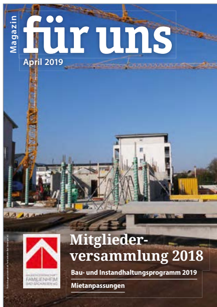
Titelfoto: Baustelle Aufeld
