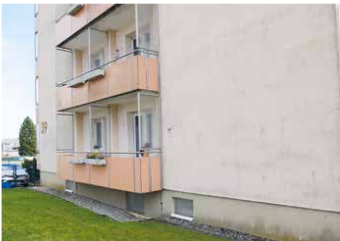
Hebelweg 39 Ansicht Nord
