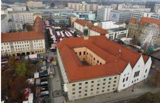
Das Alte Rathaus (Rückseite), das sich am Alten Markt befindet.
